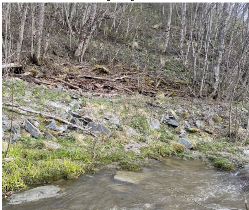
(b) Sprengstein brukt til erosjonssikring langs bekken
