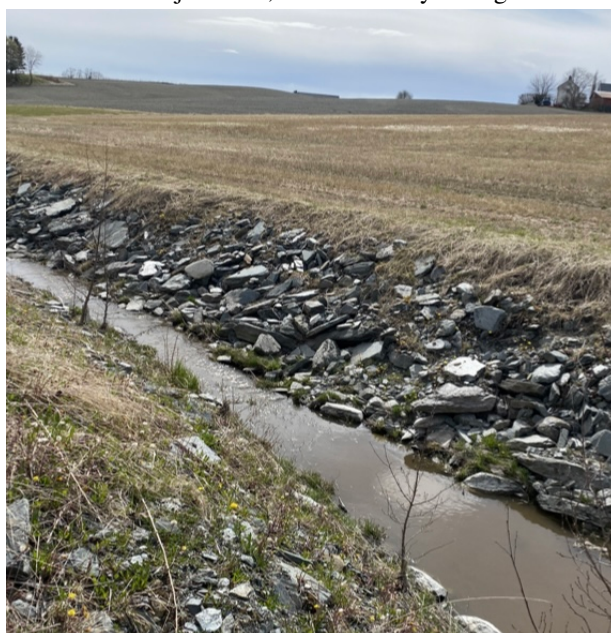
(b) Sprengstein brukt som erosjonssikring langs bekken ved utglidningsområdet
