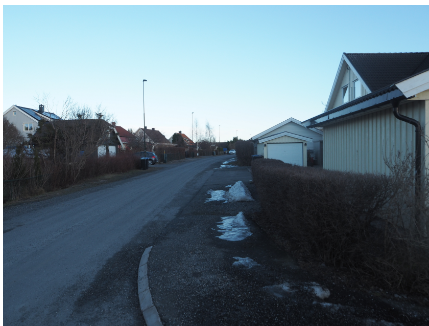
Figur 3.11: Typisk bebyggelse i det setningssensitive området over Carlbergtunnelen
