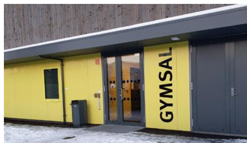
Figur 24 Tydelig merket vei til idrettshall. (foto: Skusest,2023)
