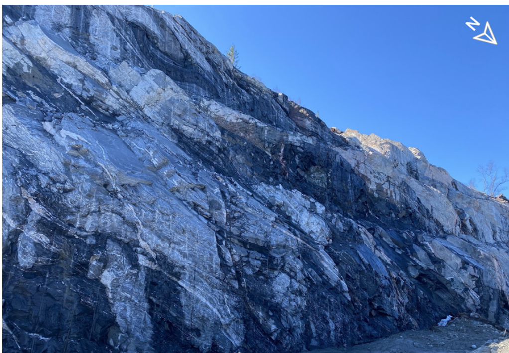
Figur 6.3: Bilde av bergskjæring Haltbakken B25. Bilde tatt 19.04.2023.
