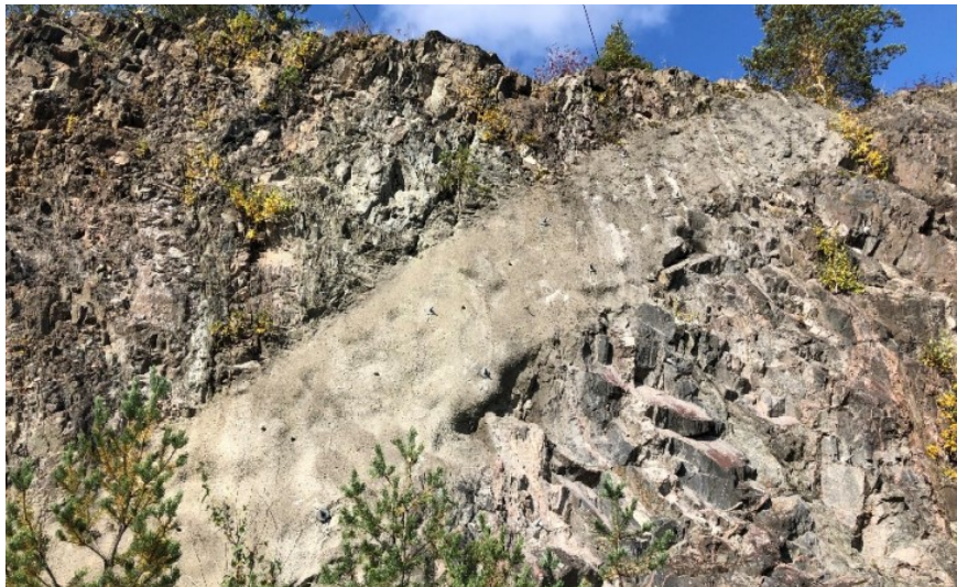
Figur 3.16: Sprøytebetong som sikringstiltak av en svakhetszone gjennom en bergskjæring (Statens Vegvesen 2023).
