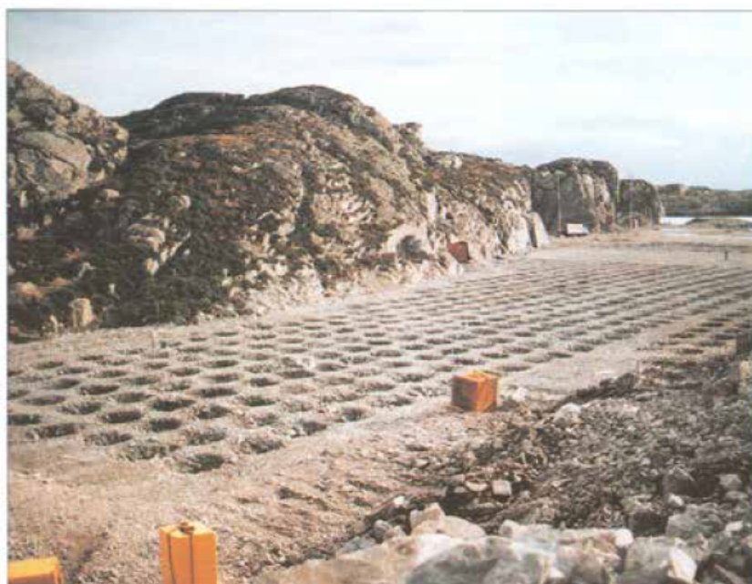
Figur 1-11-2 Dypkomprimering, Kollsnes. (Foto: Noteby)
