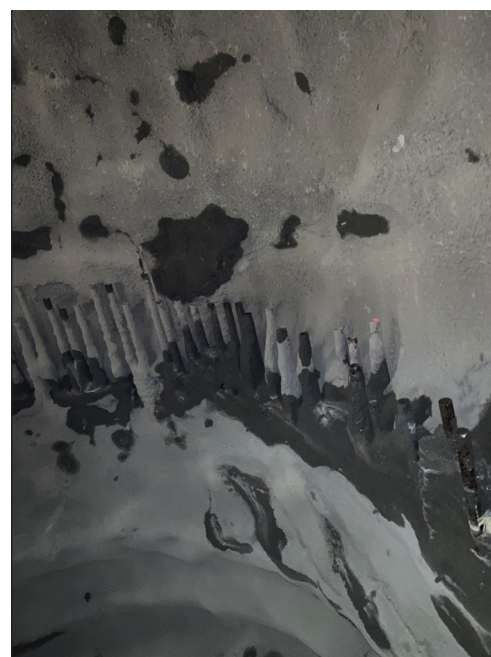
(b) Fuktkartlegging pelenummer 9130 rørskjerm
