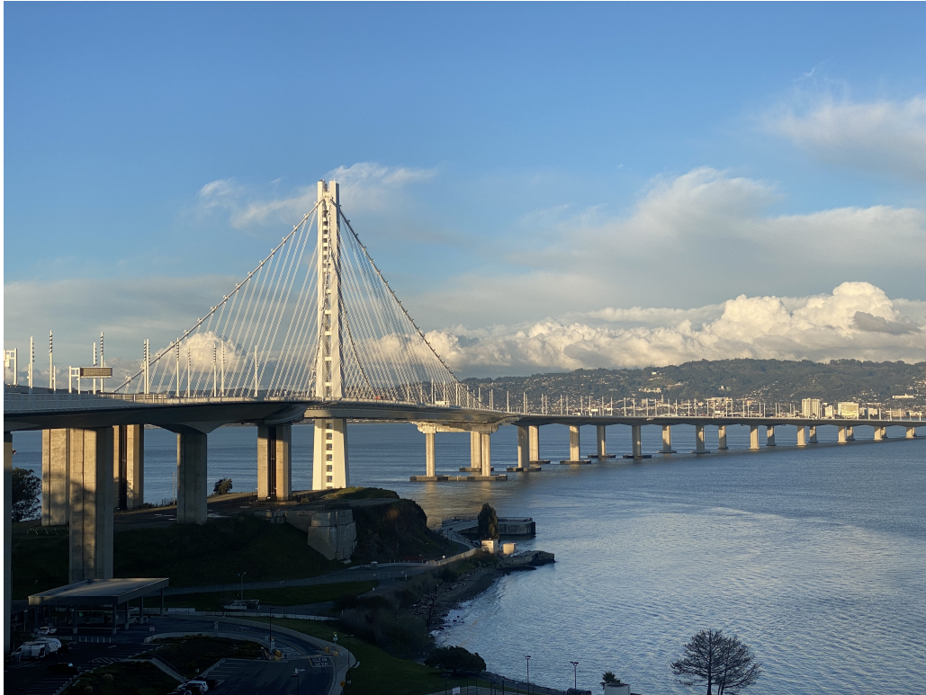
Figur 3.2: Bilde av San Francisco-Oakland Bay Bridge
