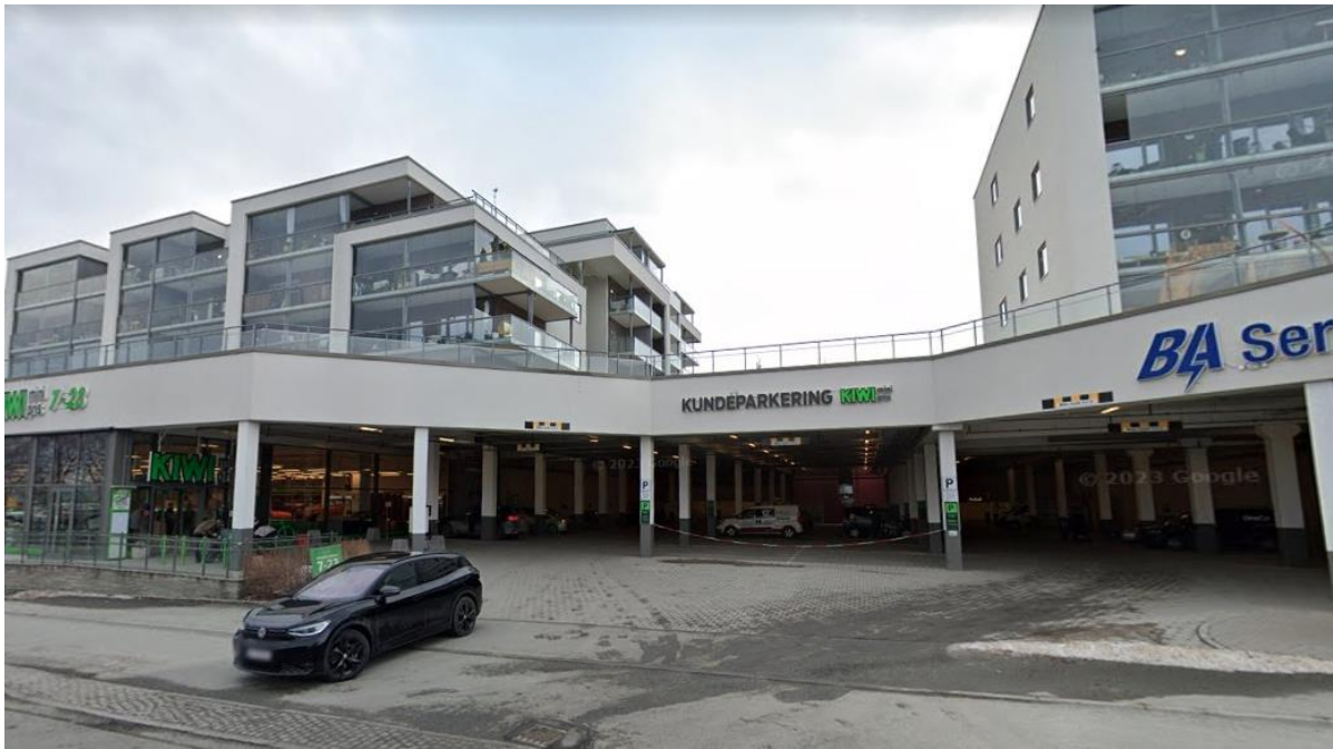
Figur 11. Område langs Ingvald Ystgaards veg oppleves utrygt. Tilkomst til boligområde i bakgrunnen er via adkomsttrapp i parkeringskjeller (Google Street View, 2023).
