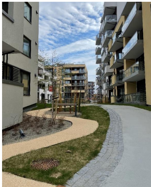
Figur 36. Forbindelse til nytt gårdsrom viser grad av opparbeiding her.
