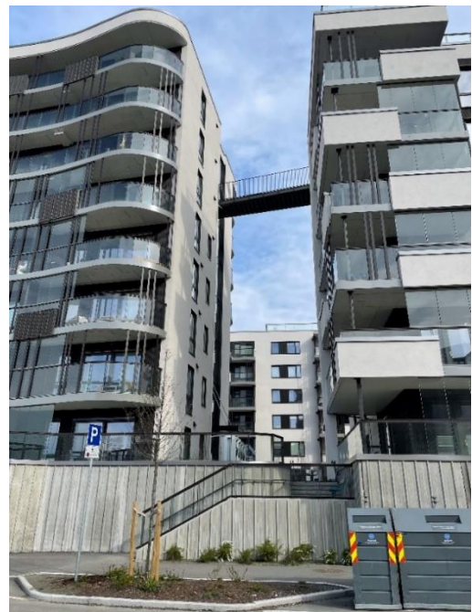
Figur 29. En noe mindre inviterende adkomst fra Ladebekken.
