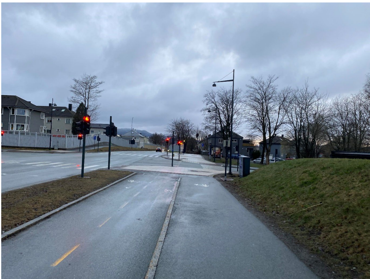
Figur 38: Eksempelbilde på "dårlig gjennomgående løsninger" fra Innherredsveien, i krysset med Persaunvegen.
