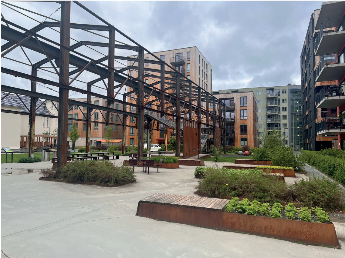
Figur 41: Oversiktsbilde over konstruksjonen fra Berg Maskin.
