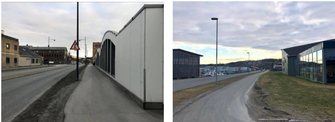
Figur 13: Fra venstre til høyre. E6 som går gjennom byen. Hovedvei på Nordsidleiret som fører til boligområdene på Nordsidleiret samt Bogen. Bilder tatt 19.april 2023.
