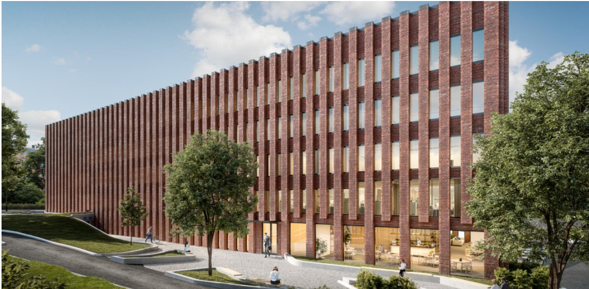
Figur 9: Illustrasjons bilde av Kongens gate 87. Hentet fra Entra sine nettsider. Kilde: (Entra, u.å.)
