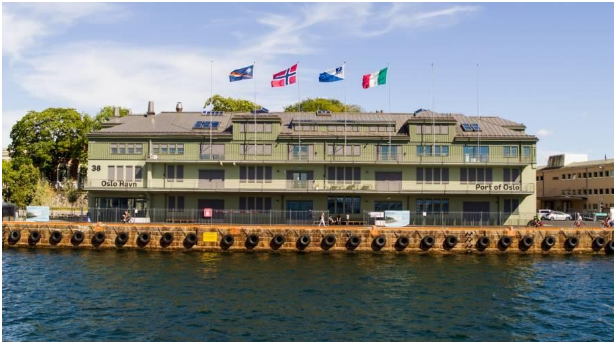
Figur 12: Skur 38, Bilde hentet fra FutureBuilt sine nettsider. Kilde: (FutureBuilt, 2023)
