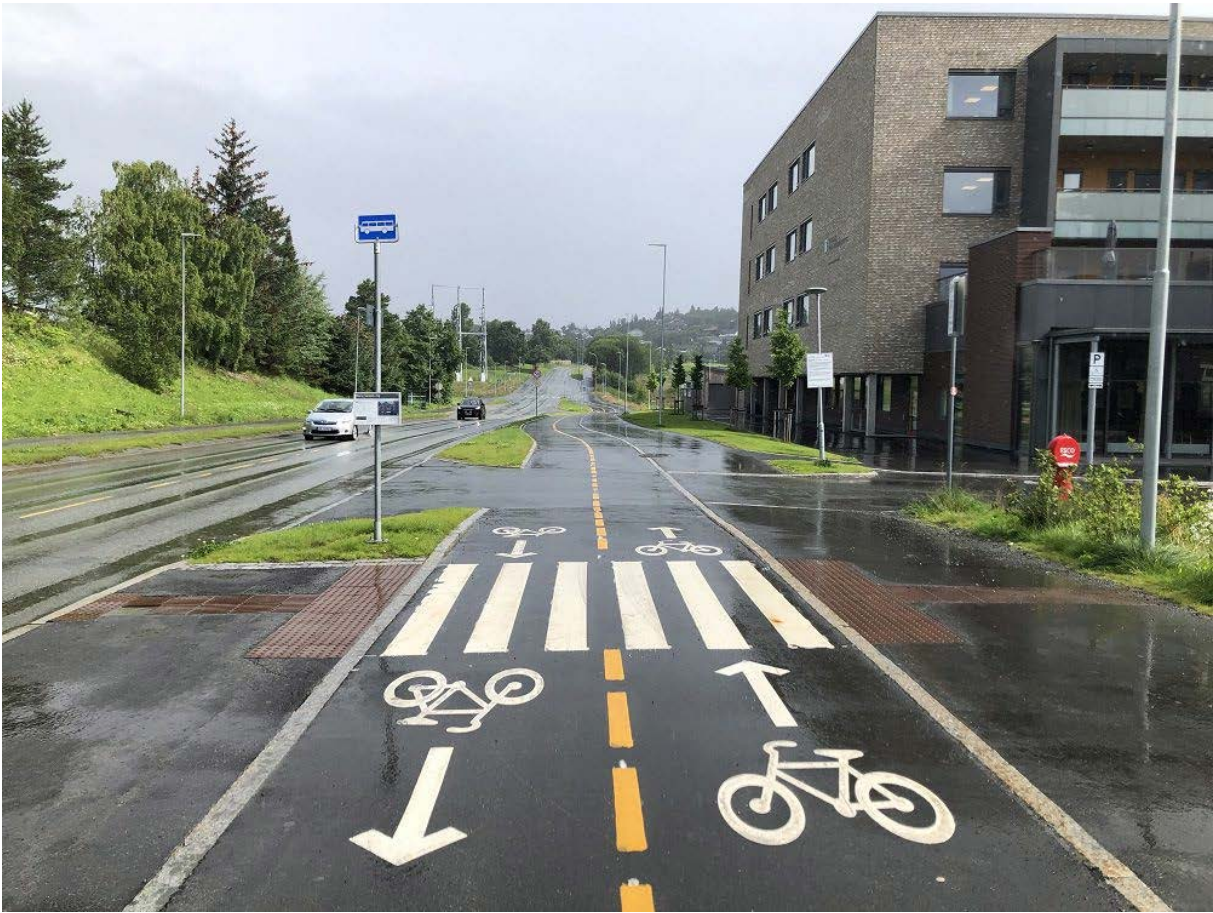
Figur 22: Fotgjengerovergang 1, fotgjengerfelt over sykkelveg i begge retninger.
