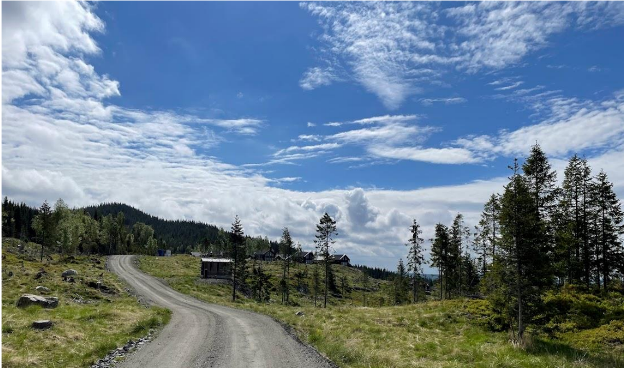
Figur 8: En håndfull hytter rakk å bli ferdigstilt i Svarthaugen Vest før byggestoppen inntraff. I Bakgrunnen ligger Svarthaugen (Foto: Yngvild Skjeldnes).
