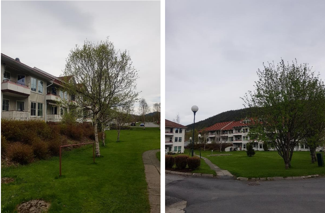
Figur 1.2.5 og 1.2.6: Hagen borettslag fasade og parkområde
