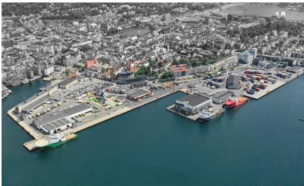
Figur 14 - Dagens situasjon på Dokken (Brun, 2021, Fotograf: Bergen kommune)
