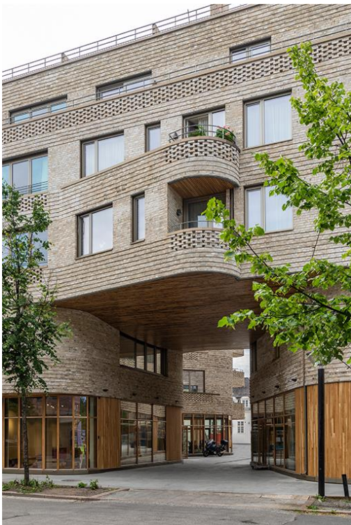
Bilde 3: Fasade med murfletting (Murmesteren, 2021
