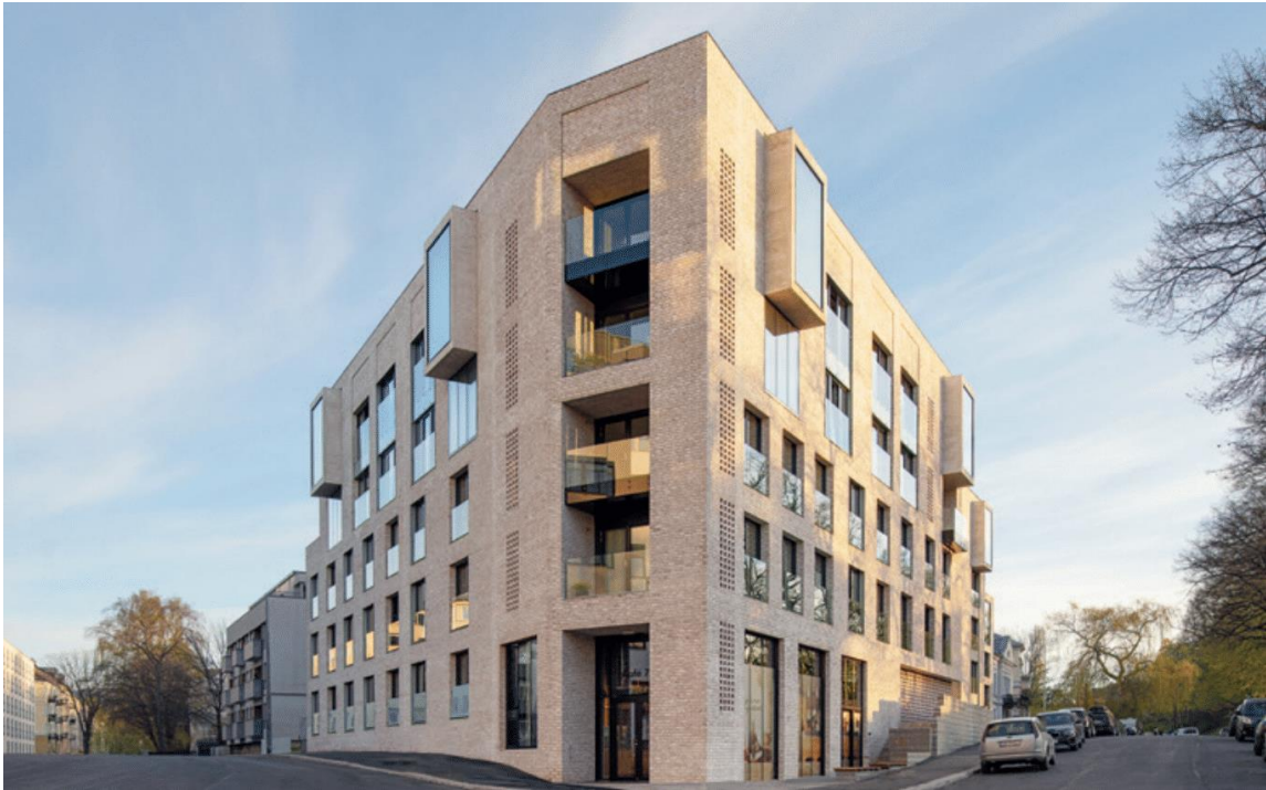
Bilde 10: Oversiktsbilde Pilestredet 77-79 Mur+Betong, 2020)
