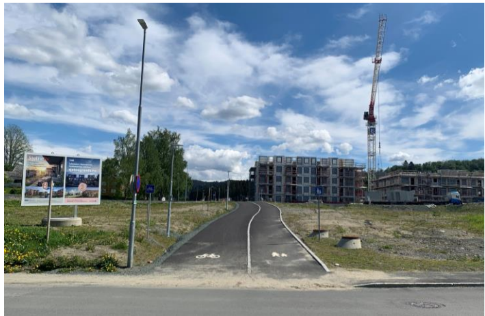
Bilde 14: Nye leiligheter er under bygging ved Sjetnemarka. Ny gang- og sykkelveg er på plass før bygningene. Fotografi tatt 30.05.2022.
