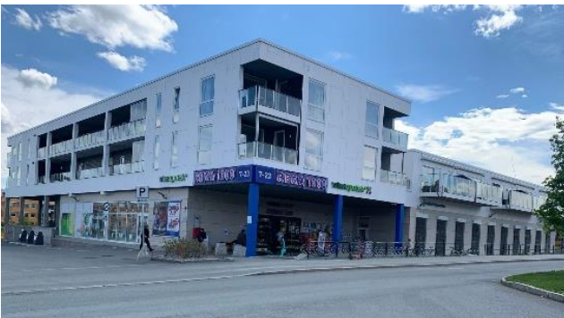
Bilde 15: Hallset hage med Rema 1000, Vitus apotek og legekontor i førsteetasje, samt leiligheter i andre- og tredjeetasje. Fotografi tatt 30.05.2022.
