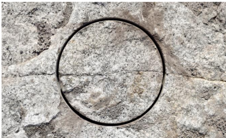
Figur 2.2: Utført slisseboring (Hanssen og Rognlien, 2020).
