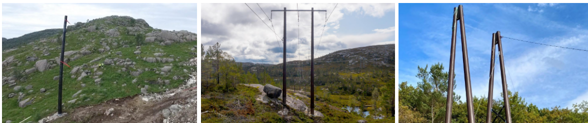
Figur 1.2: Eksempel på singelmast, H-mast og A-mast (Comrod, 2023c).
