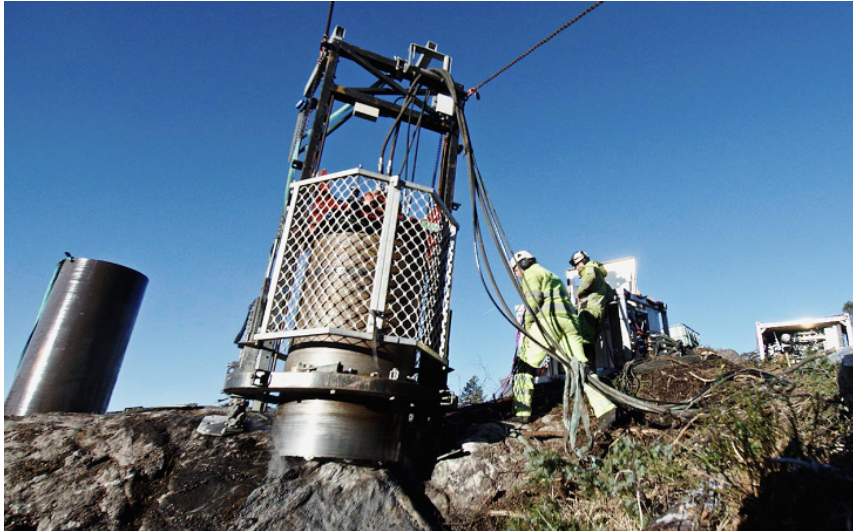
Figur 2.1: Comrods egenutviklede borerigg for slisseboring (Comrod, 2023a).
