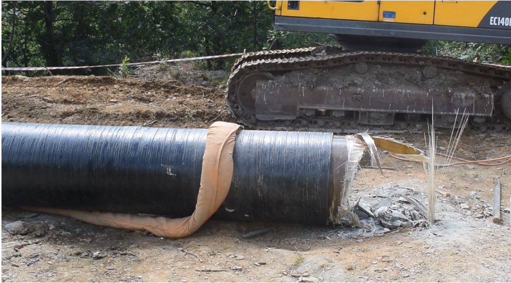
Figur 5.6: Brudd i fundament ved fullskallatesting på NAG (Comrod, 2018).
