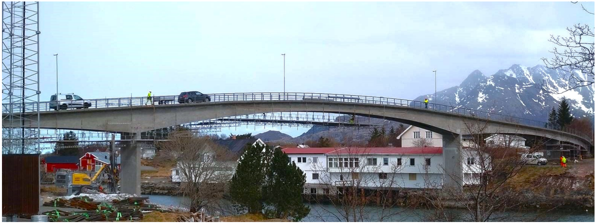
Figur 1.0.1: Bilde av Herøysund bru [3]
