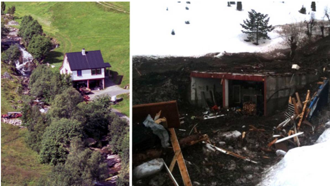
Figur 1.1: Før- og etterbilde viser de store ødeleggelsene av huset i balestrand. Foto: FJELL-ANGER WIDERØE/NRK, hentet fra [6].
