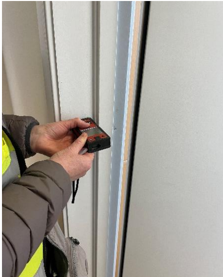
Figur 10 Ombrukskartlegging - fysisk oppmåling av dørbredde.
