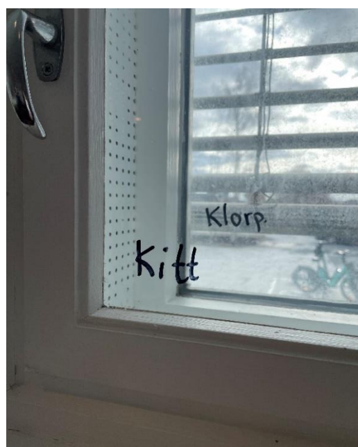
Figur 9 Ombrukskartlegging - fysisk merking av kjemikalier i vindu.
