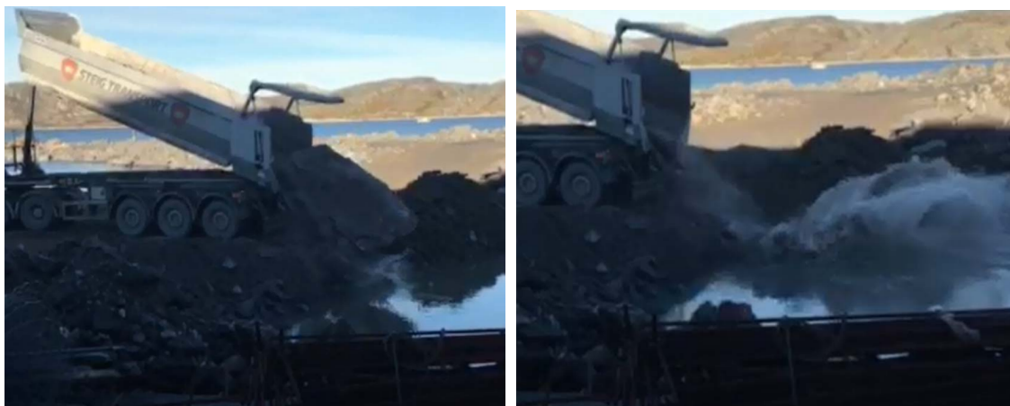
Figur 22: Bildene viser at på minst en anledning har det blitt dumpet en blokk på 10\text{m}^3 , hentet fra (Multiconsult 2017).
