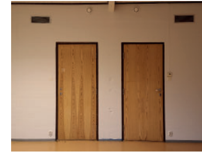
AVTREKK- OG TILLUFTSVENTILER
