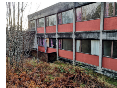
BETONGSØYLER OVER TO ETASJAR
