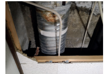
RØYRFØRING BAK HIMLINGSPLATENE
