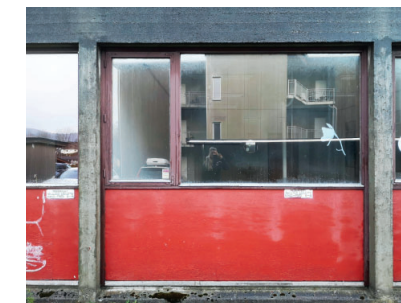
BETONG OG FINÉRPLATER + VINDAUGE
