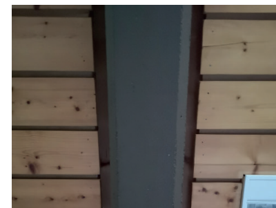
PLANKEDEKKE OG BETONGDRAGAR
