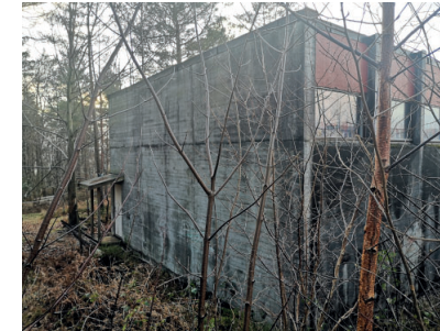
BERANDE YTTERVEGG I BETONG
