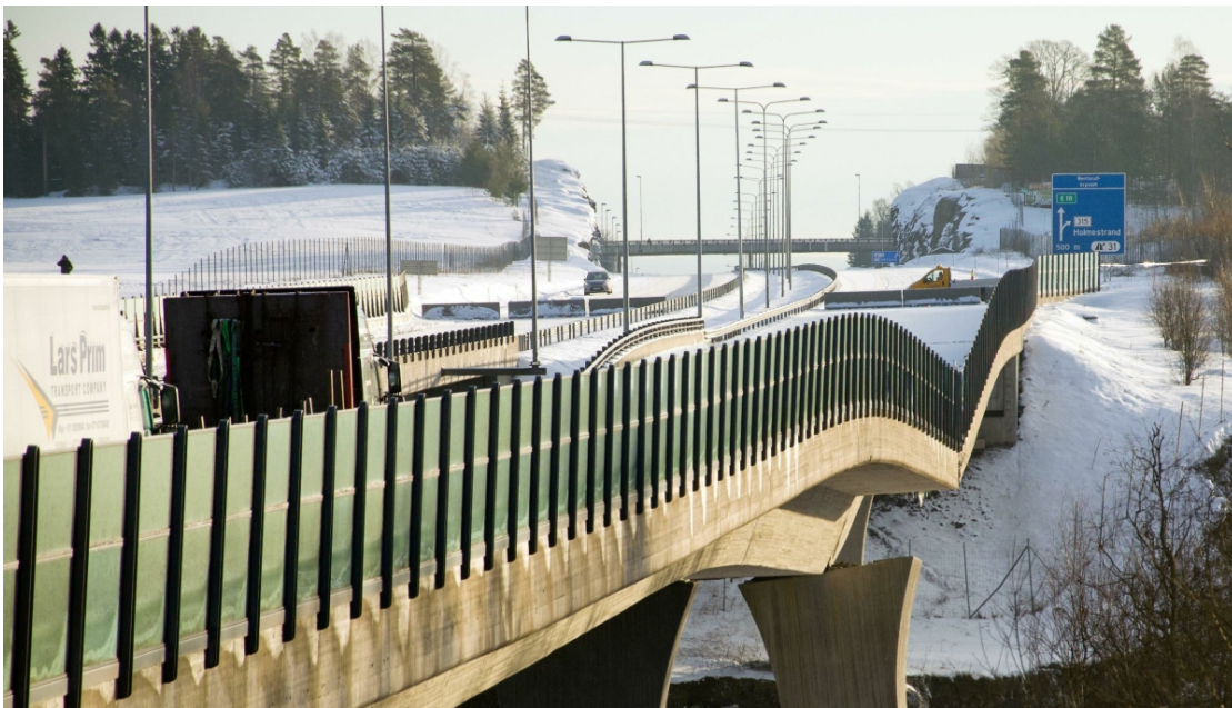
Figur 12: Nærbilde av Skjeggestadbrua etter "kollaps" [38]
