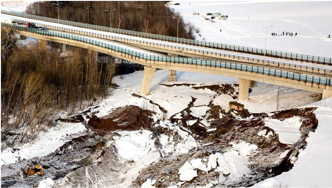
Figur 11: Perspektivbilde av Skjeggestadbrua etter "kollaps" [37]
