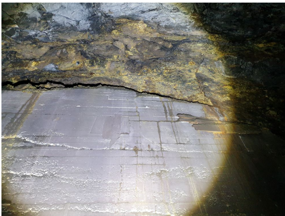
Figur B.9: Bergmassen med gult forvittringsbelegg øverst og betongvegg med sprekker under på Heibergløkka tverrslag (Foto: Eivind Sømme Berget).
