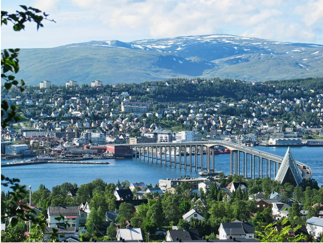
Figur 1-1 Tromsøbrua, Bildet er lånt av fotograf Mark Ledingham
