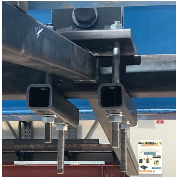
Figur 4.4: Opplageret til prøvestykket ved forskyvningspunktet
