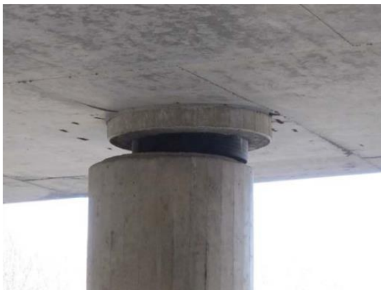
Figur 2.5: Utvidelse av bruplate og forskyvning av søyleopplegg [11]
