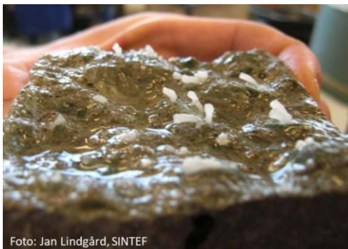
Figur 2.1: Alkaligel i en betongprøve [6]
