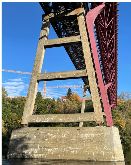
Figur 4.5: bilde av pilarramme på betongsåle [Nina Valnes]
