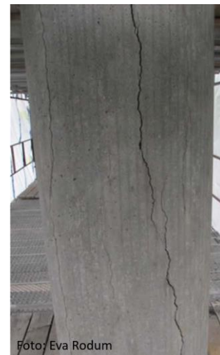
Figur 2.4: Sprekker parallelt med lastretningen [11]
