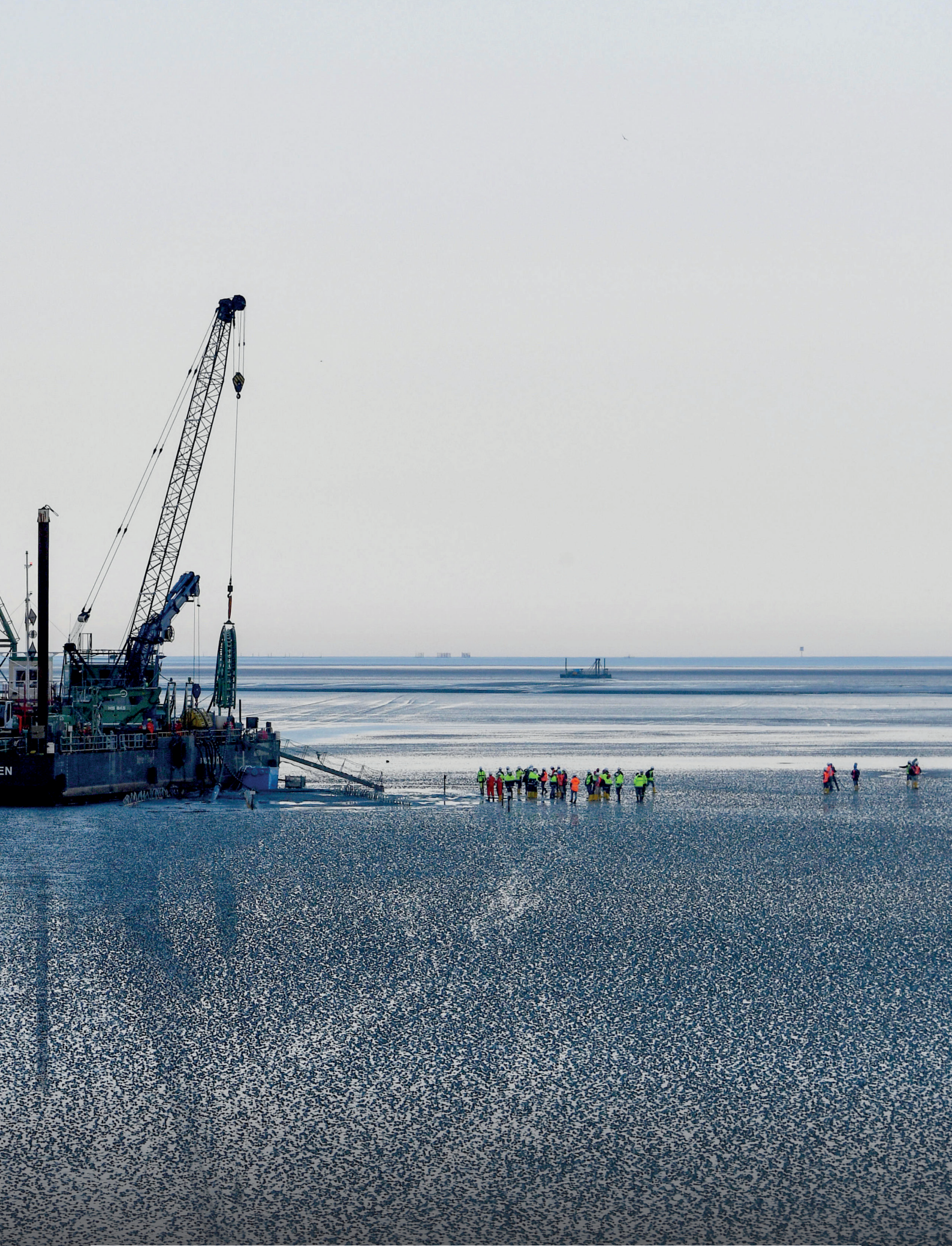
19. juni 2019, Schleswig-Holstein, Büsum: Enden av den 516 kilometer lange undervannskabel blir dratt i land av kabelleggingskipet "Boka Connector". NordLink er navnet på strømlinjen som for første gang koblet sammen strømmarkedene i Tyskland og Norge. Foto: Carsten Rehder / dpa
