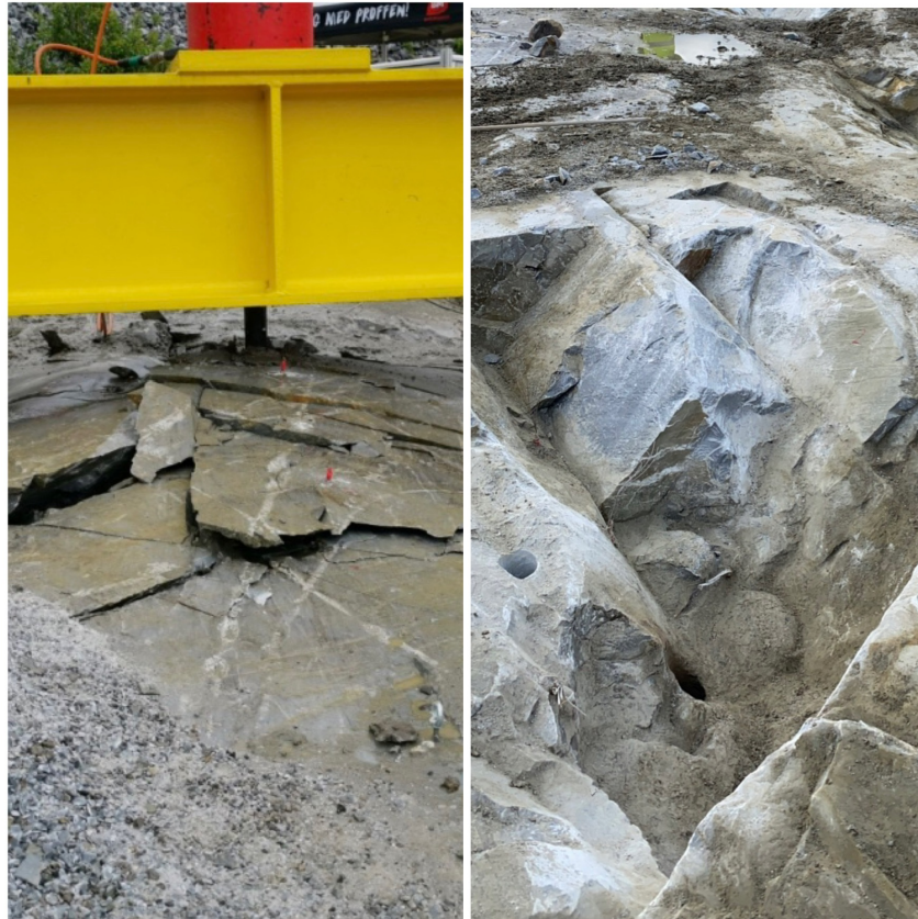
Figur 4.13: Bilder før og etter rensk av bruddmaterialet. Bildet til venstre viser bruddkrateret til anker A1m og bildet til høyre er av bruddkrateret til B1.5m
