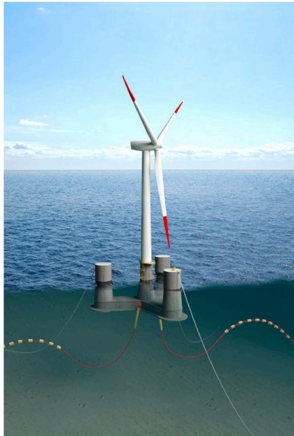
Fig. 1. The 10-MW OO-star FOWT [13].
