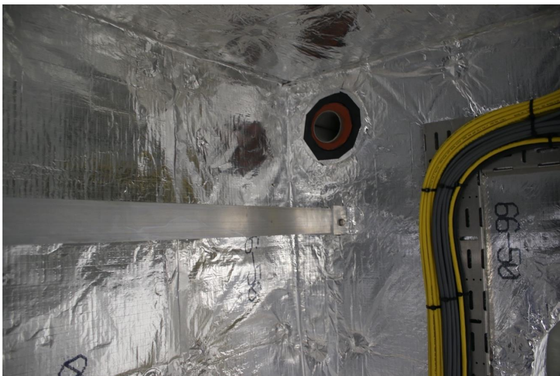
Figur 48 Ventilasjonsinnløp på MS Fjordled (Foto: Eget)
