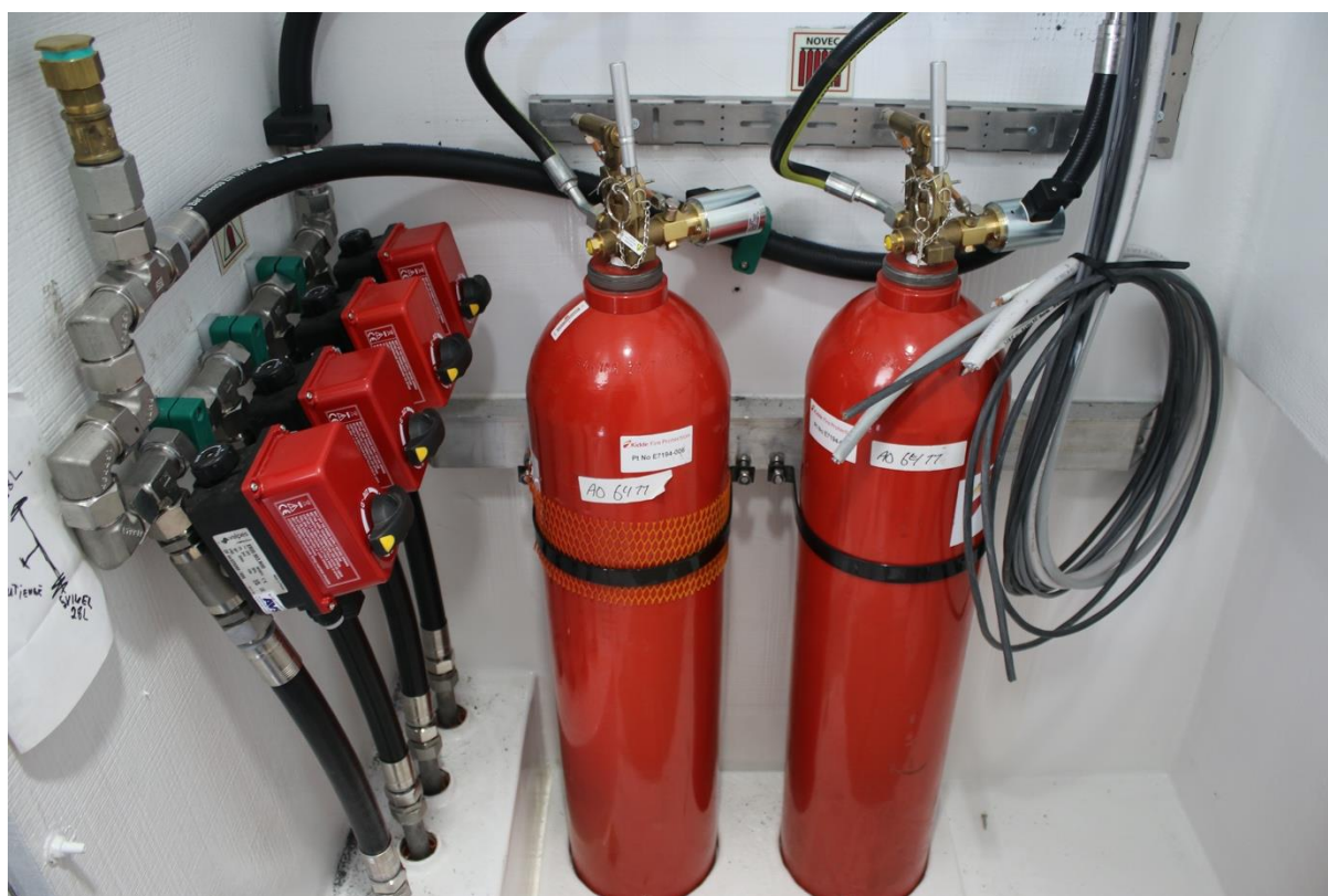
Figur 46 Slukkesystem om bord på MS Fjordled (Foto: Eget)
