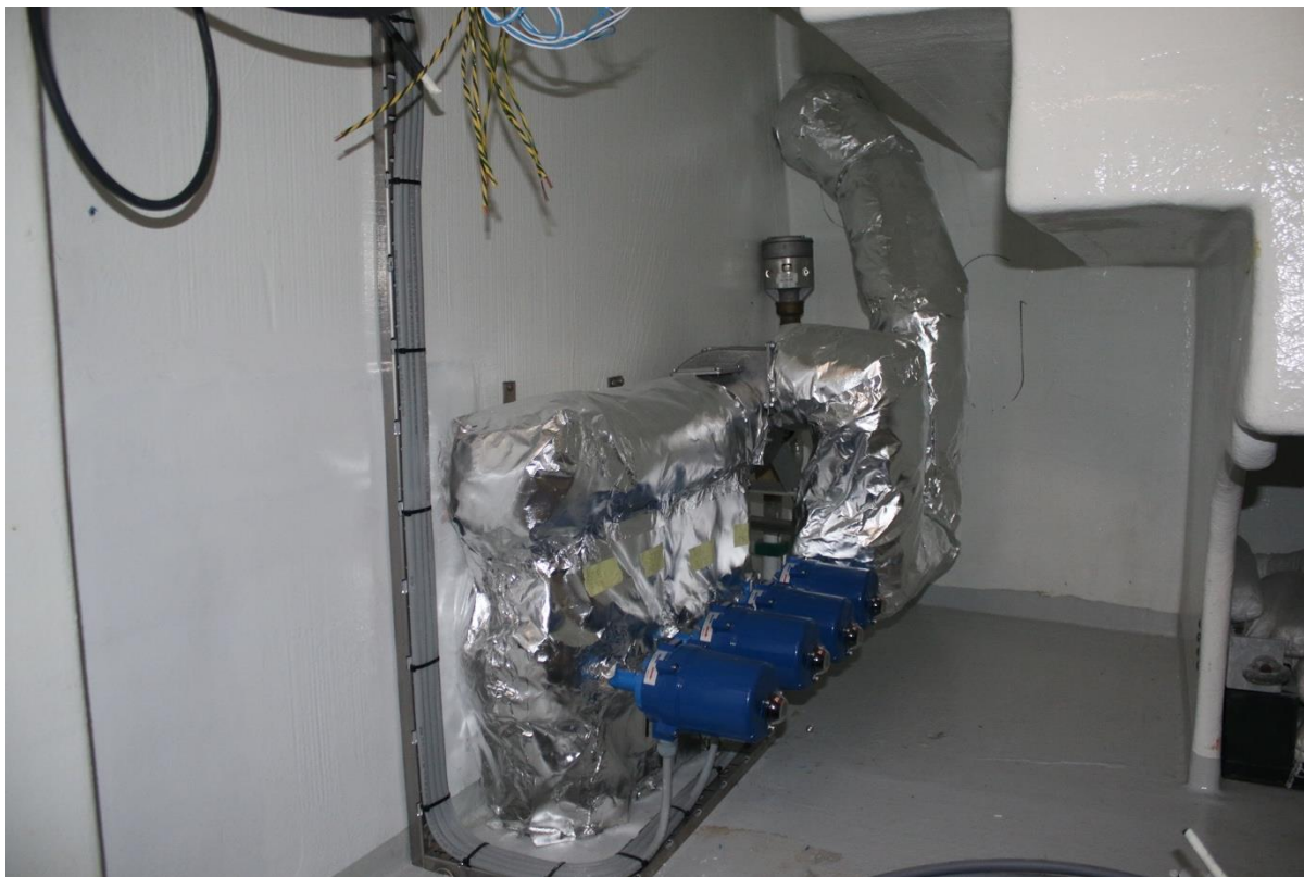
Figur 47 Ventilasjonssystem om bord på MS Fjordled (Foto: Eget)
