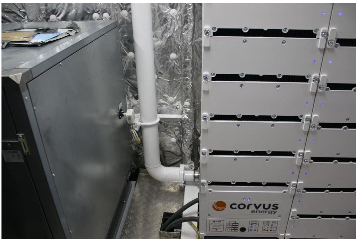
Figur 37 Ventilasjonssystem om bord på MF Festøya (Foto: Eget)
