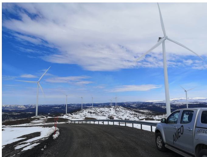
Figur 1: Vindturbiner på Stokkfjellet.
