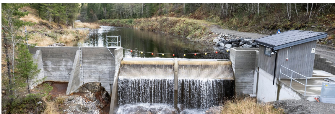
Figur 31: Mølnåa elvekraftverk i Selbu [73].
