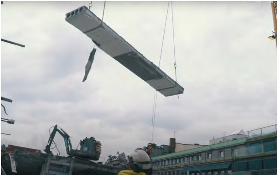
Figur 12: Demontering av HD-element på Regjeringskvartalet (Skanska Norge, 2020)
