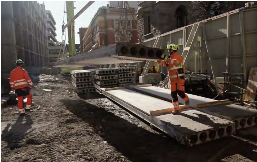
Figur 13: HD-elementer stables på byggeplass før transport (Skanska Norge, 2020)
