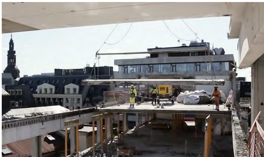
Figur 16: Kraning av brukt HD-element (Skanska Norge, 2020)
