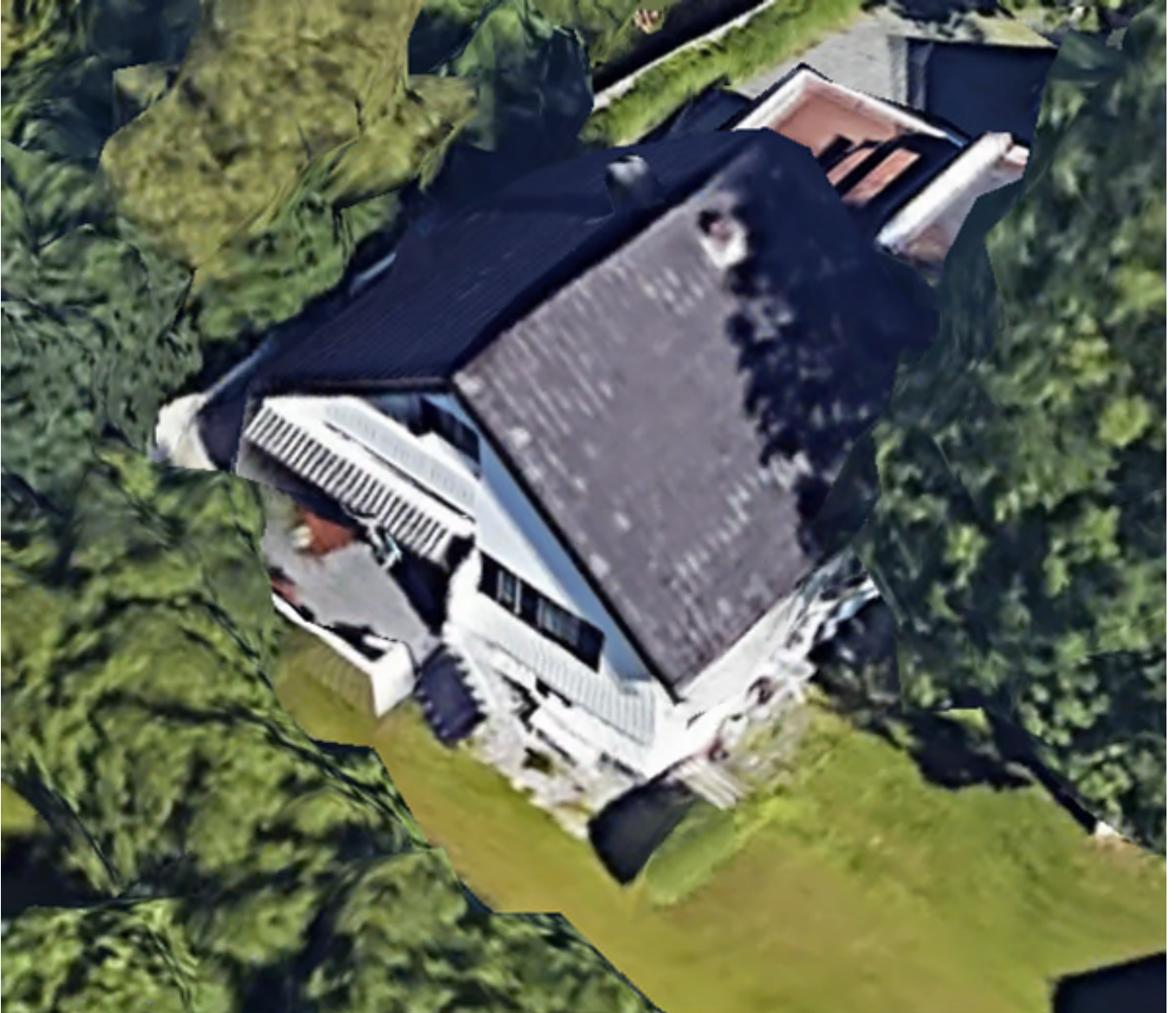
Bilde 2, viser hus fra sør - eksisterende konstruksjon
