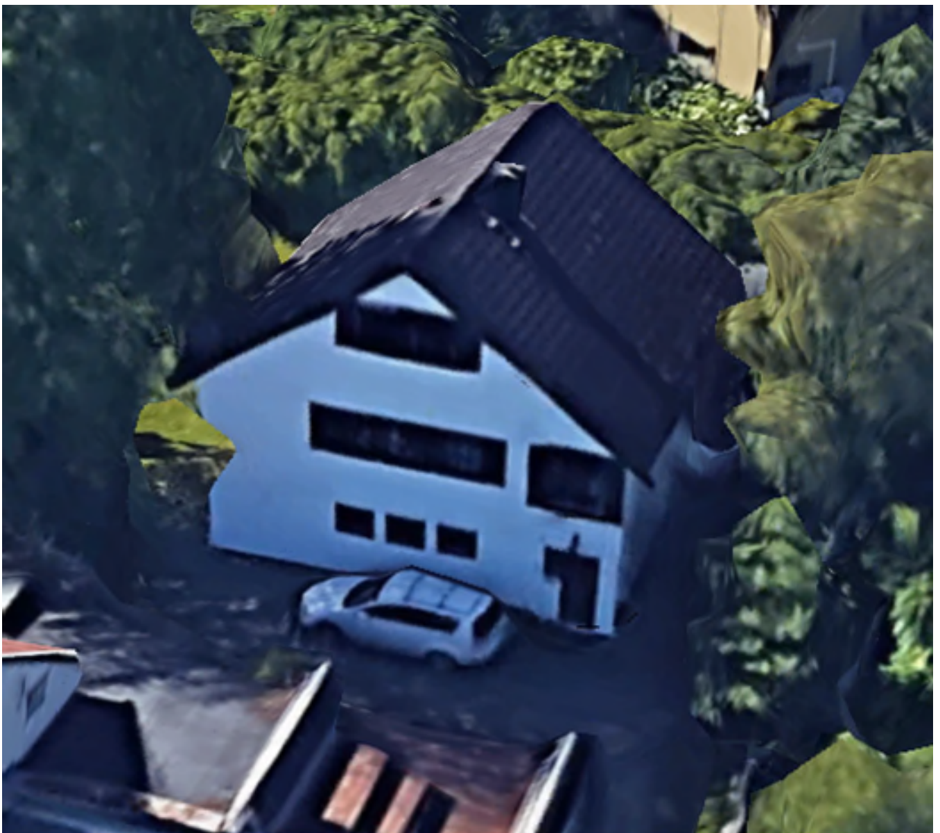
Bilde 1, viser hus fra nord - eksisterende konstruksjon
