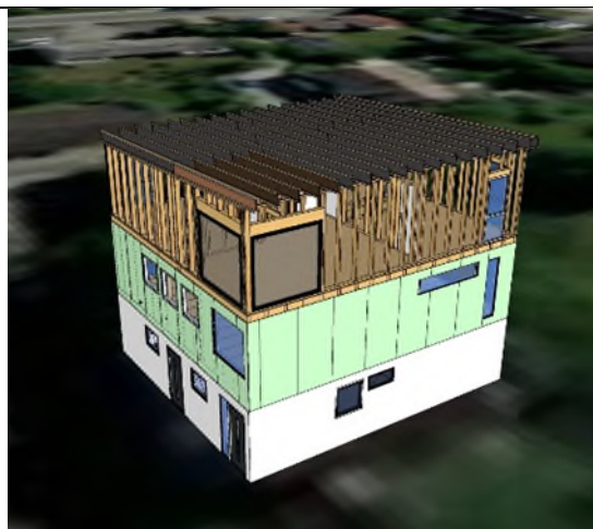
Husets fasade uten kledning, og tak-detalljer, sett fra nord/øst
