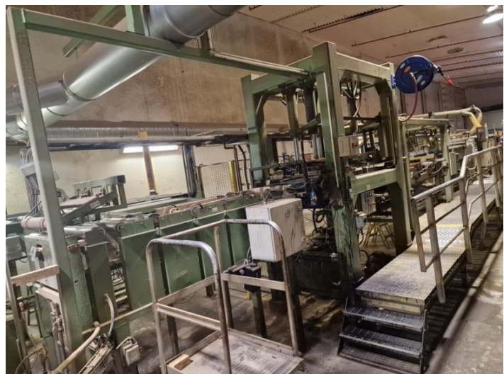
Figure 19 3 lag med Steico plater presses sammen, foto: Privat
