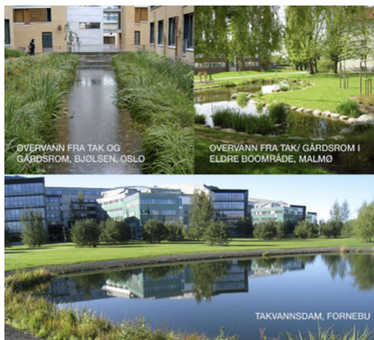
Figur 8 Fordrøyningsdammer for overvann fra tak og gårdsrom. Kilde; (Enebakk kommune, Tekniks avdeling, 2020)
