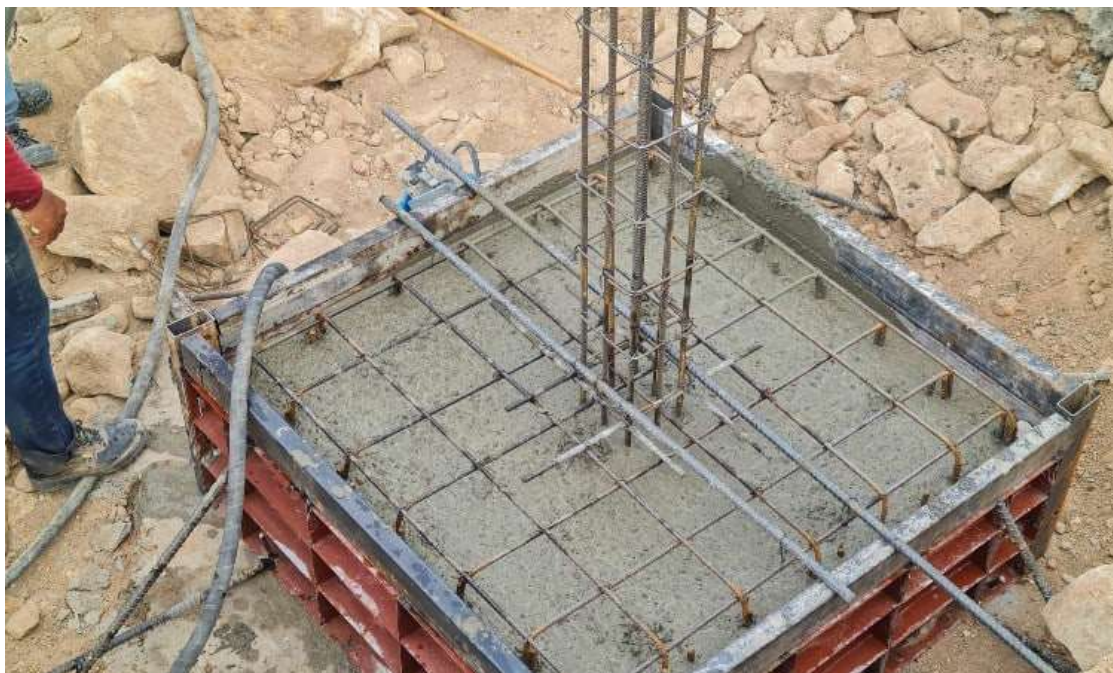
Figur 2: Punktfundament støpt på byggeplass (Sokol, u.å.)
