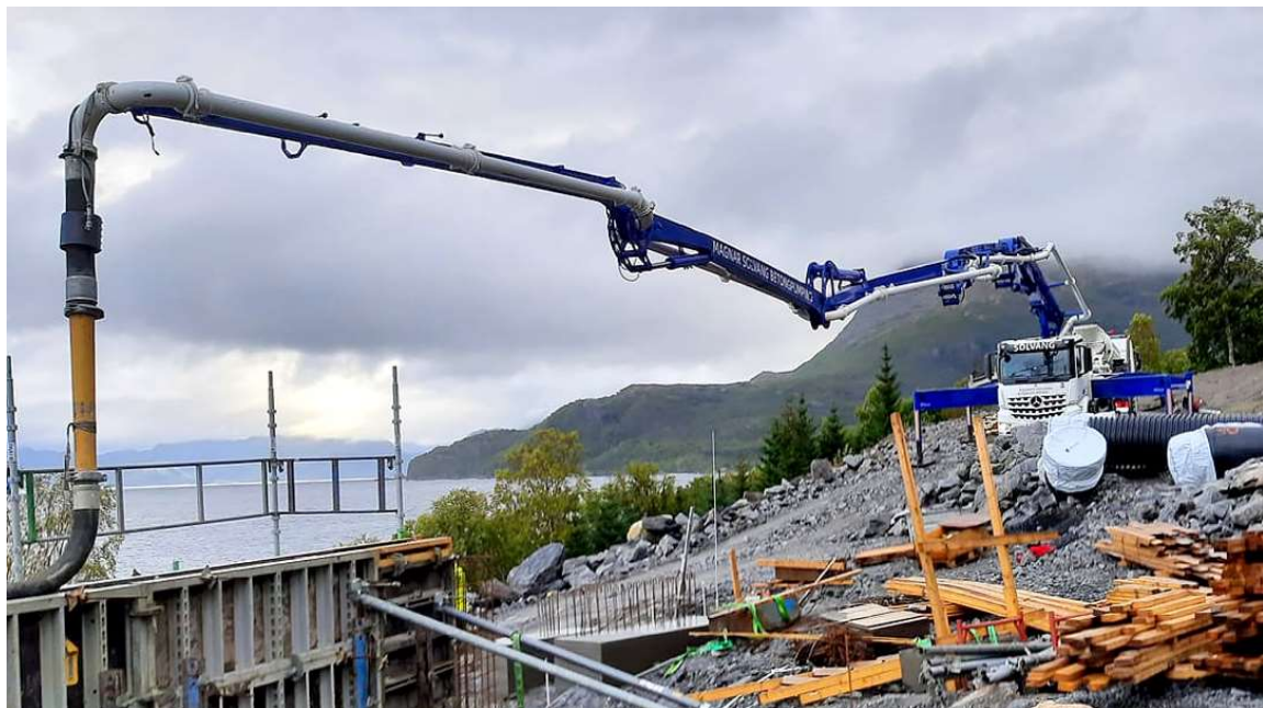
Figur 3: Pumpebil på byggeplass (Bye, 2022)
