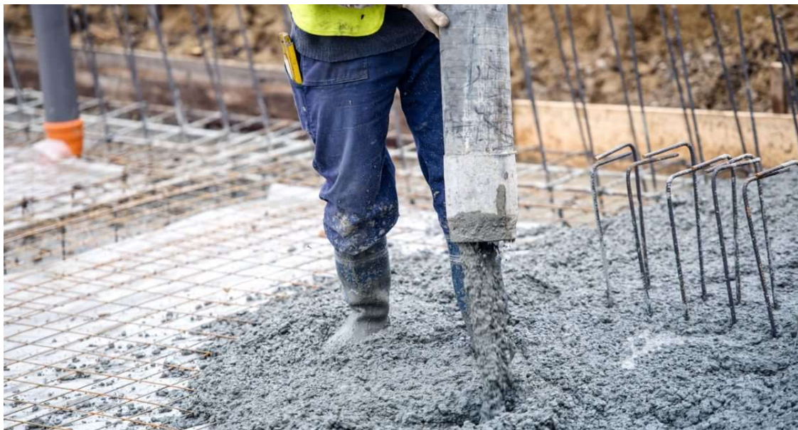
Figur 1 Plasstøping av betong (Kontrollrådet, u.å.)
