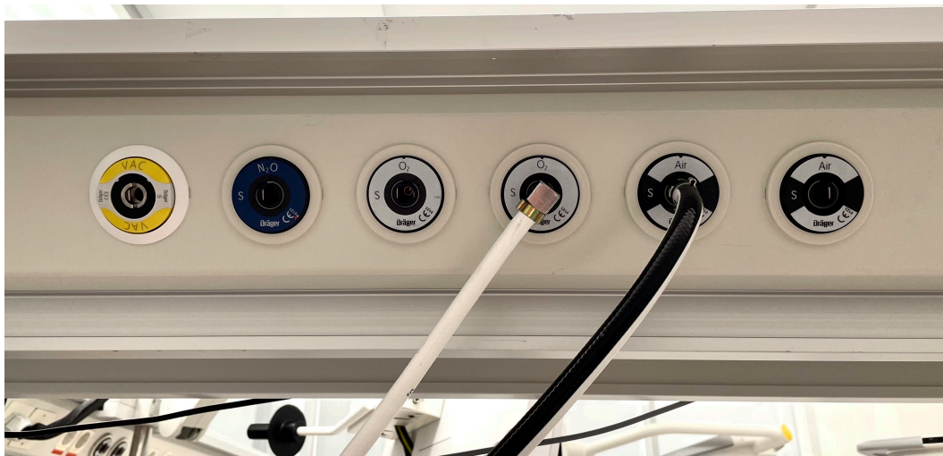
Figur 25: Gassuttak på operasjonsstue, St.Olavs
