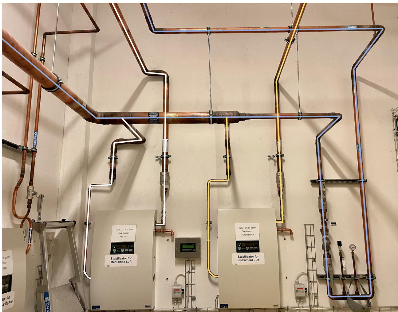
Figur 5: Trykkstabilisator for medisinsk-, instrument- og teknisk trykkluft
