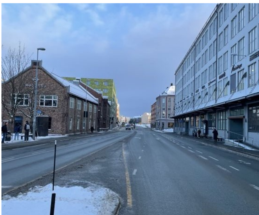
Figur 11.1: Innherredsveien ved Solsiden
