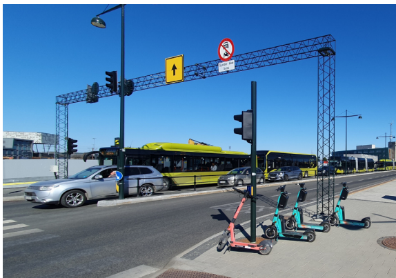
Den antatte synderen bak økt reisetid inn mot Trondheim S: Det nye signalanlegget i Gryta.
