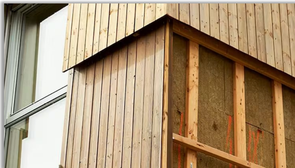
Figur 5: Fasade med Rockwool REDair Flex systemplate. (Rockwool, 2018)
