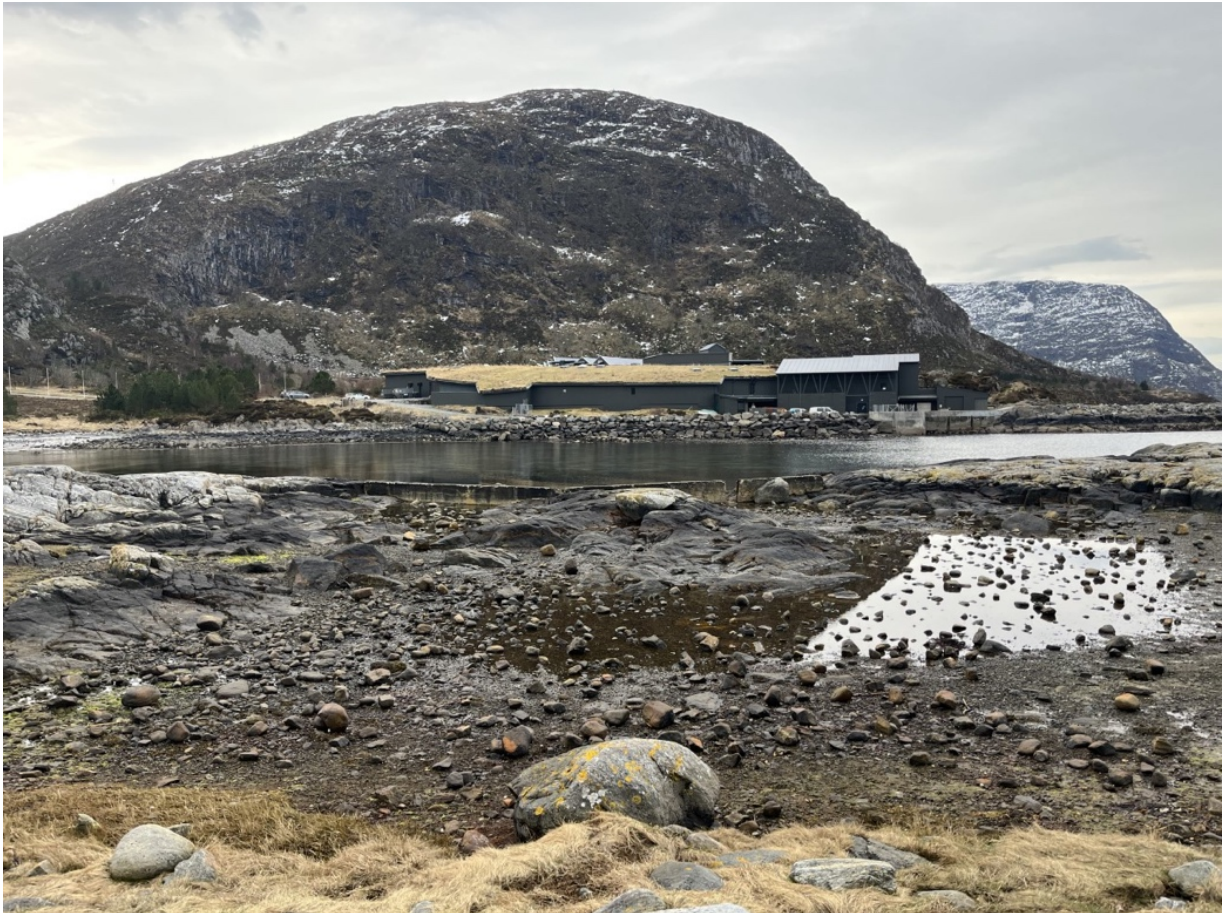
Figur 14. På Bilde ser vi krabbedammen og murene etter varmebassenget.
