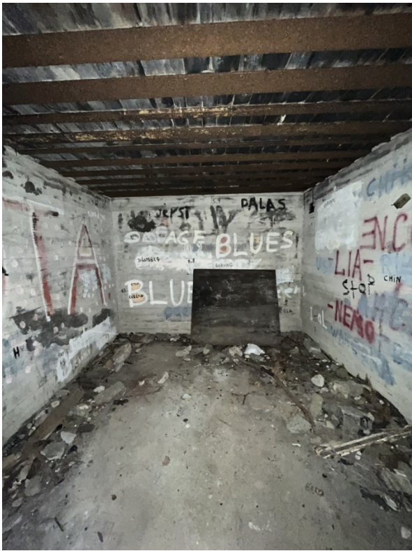
Figur 17. Innsiden av en bunker.
