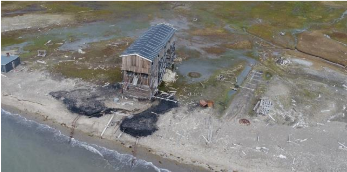
Vedlegg 4: Erosjon i Hiorthhamn i henholdsvis 2018, november 2020 og 15. januar 2021. Smia til venstre i bildet, taubanestasjonen til høyre (Sysselmesteren 2021, 26. januar).
