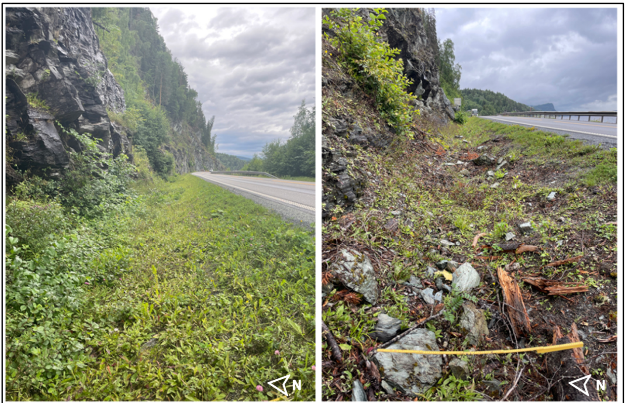
Figur 34: Bilete av grøfta på oppsida av E6 bileta er tatt mot nordaust. Viser grei breidde på grøfta, og at den har samla opp nedfall. (punkt 5 og 6 i Figur 31).
