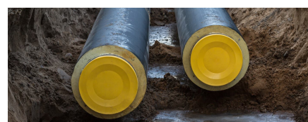
(b) Illustrasjon av tur- og returledningene i et fjernvarme distribusjonsnett. Hentet fra [120].
