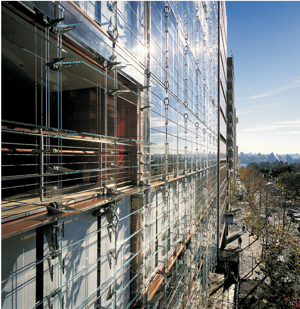
Figur 8.17: Figuren viser et eksempel på en Double skin fasade (DSF) løsning og er hentet fra artikkelen Exploring the advantages and challenges of double-skin façades (DSFs) fra Science Direct [155]
