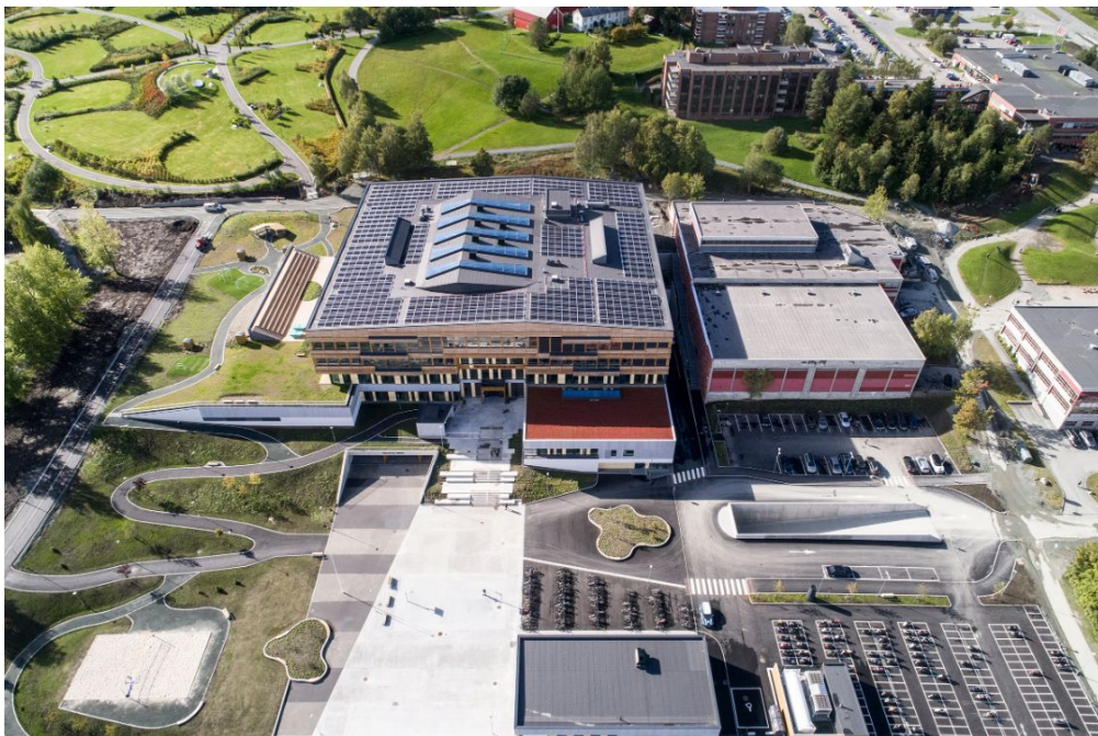
Figur 3.7: Nye Heimdal vgs har oppnådd nivået ZEB-O. Bildet er hentet fra saupstad.no [68]
