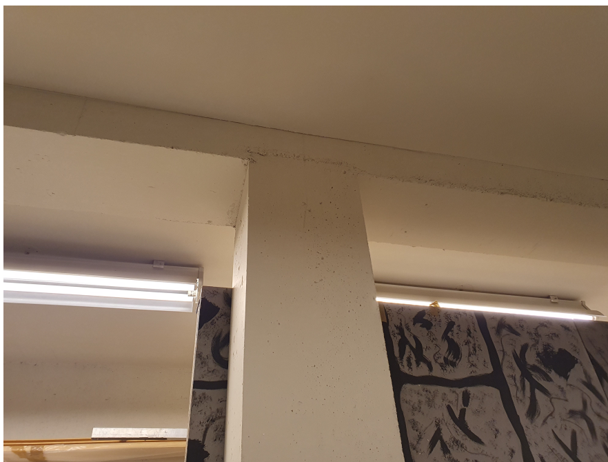
Figur 4.3.3: Søyle og bjelke under bibliotek
