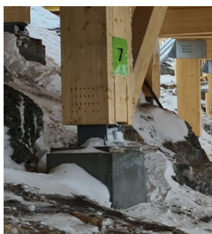
(a) Innfesting av limtre-søyle
